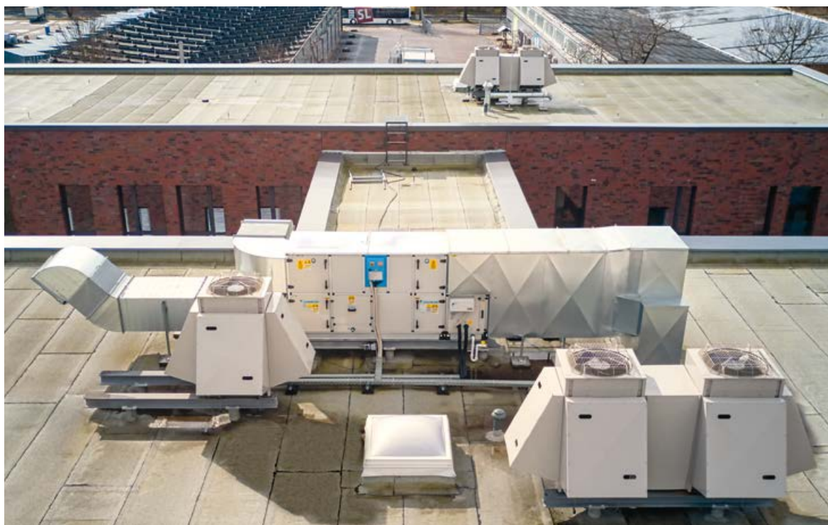
Referenzprojekt Büro: TKS GmbH in Borken
