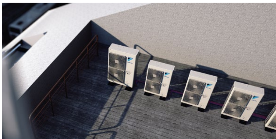
Bei der Arbeit auf der Bürotterasse
